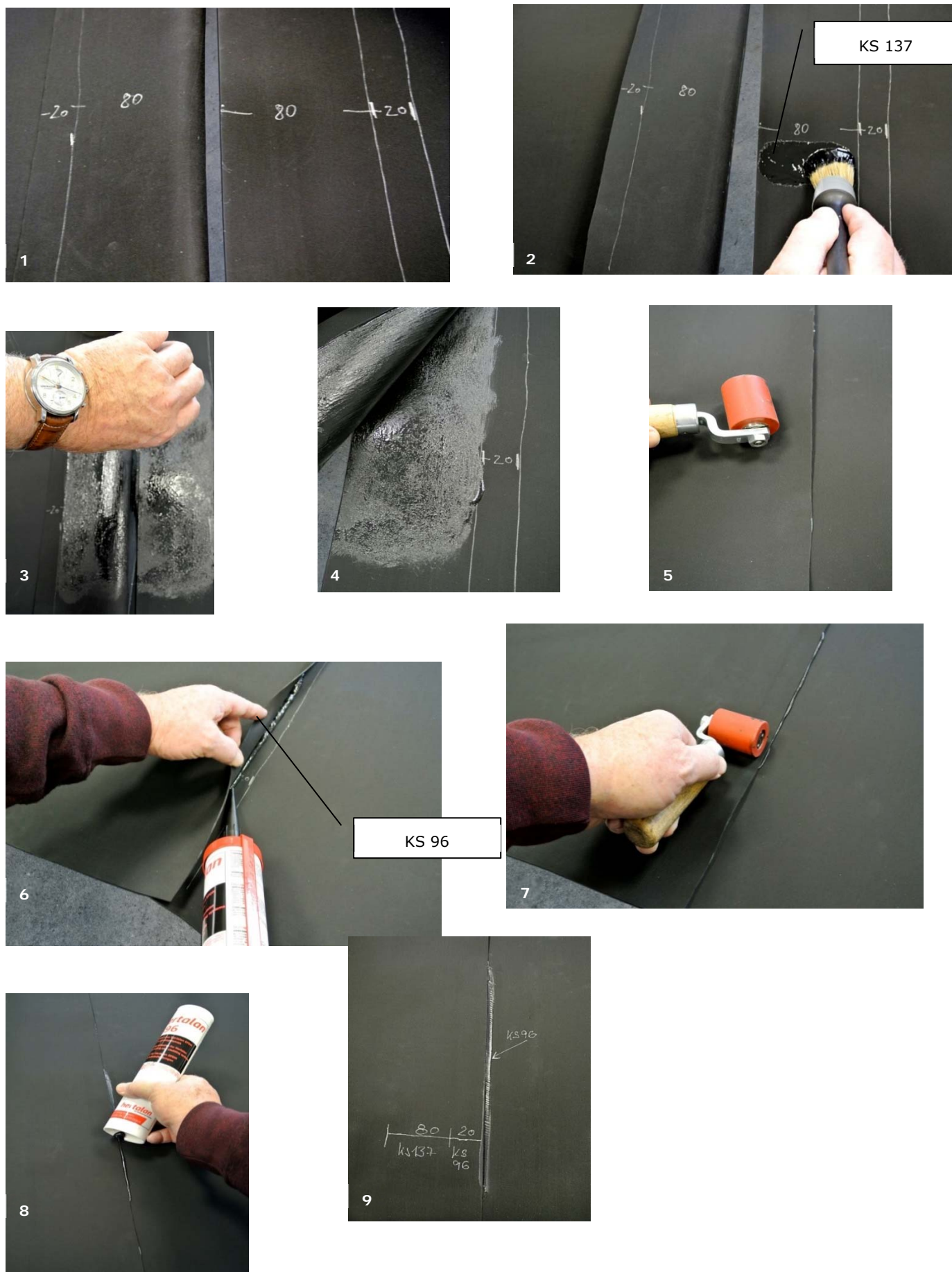
Figure 6 – Collage d'un recouvrement avec la colle HERTALAN KS 137 et le mastic HERTALAN KS 96
